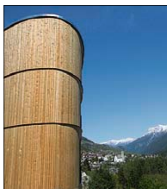
Der ellipsenförmige Neubau aus Arvenholz.
